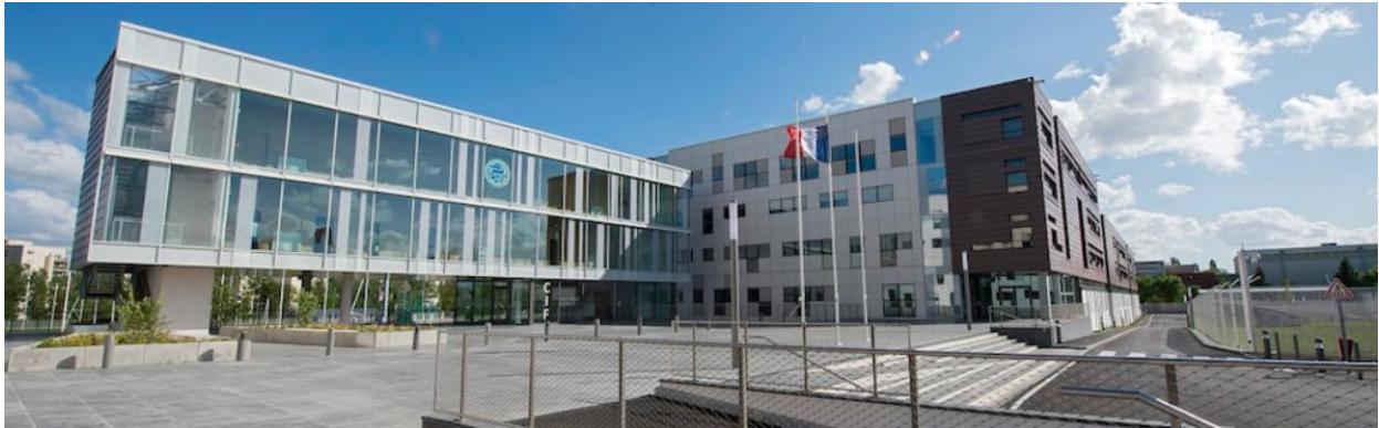
Image 3 - Locaux de l'IRCGN de Pontoise (à droite)
